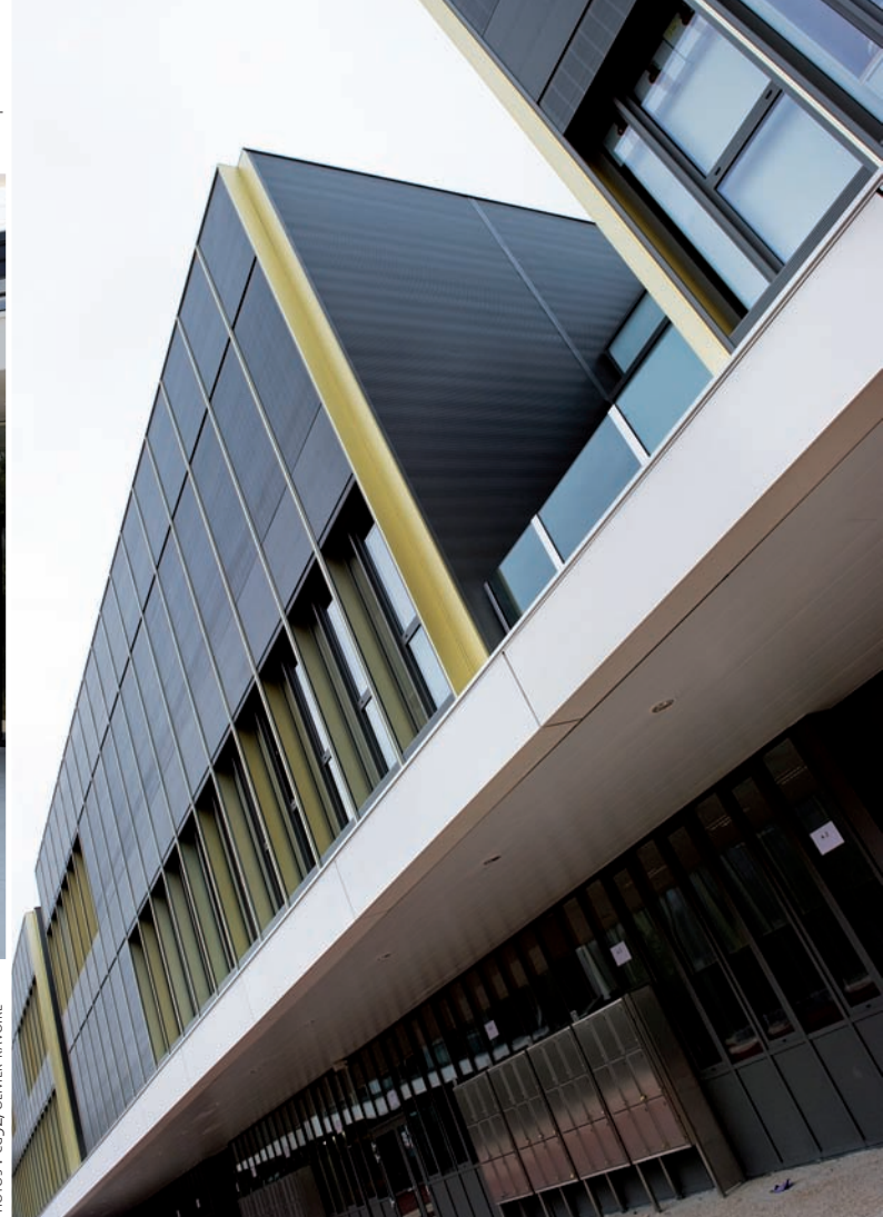
Les façades des classes avec leurs volets coulissants changent au gré des variations de l'ensoleillement (Nanterre).
